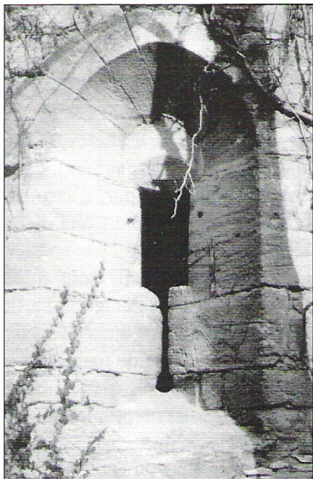
Archère de la tour d'angle gauche (photo C. Lassner).
