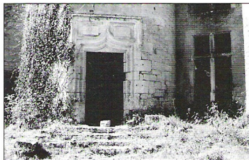
Porte de la tour d'escalier moulurée d'une triple accolade.
